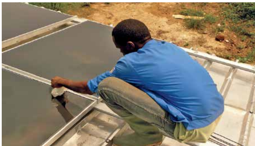
Installation von Solarmodulen auf dem Schuldach
