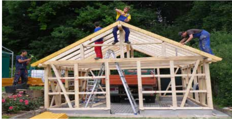
Zimmerei- und Bauhandwerk: eine der SEEHAUS Werkstätten
